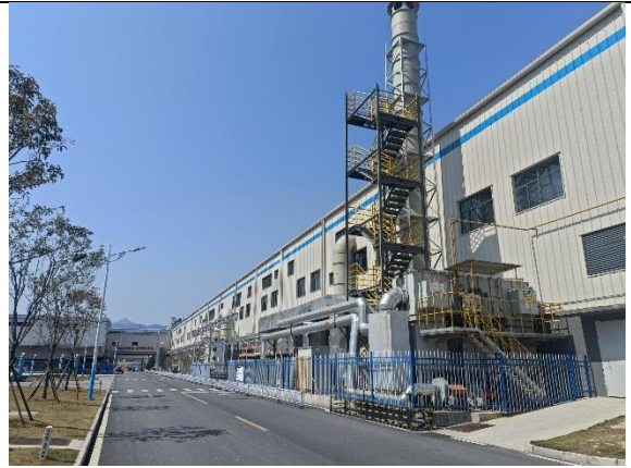
DA004 烤箱注液化成废气排放口
