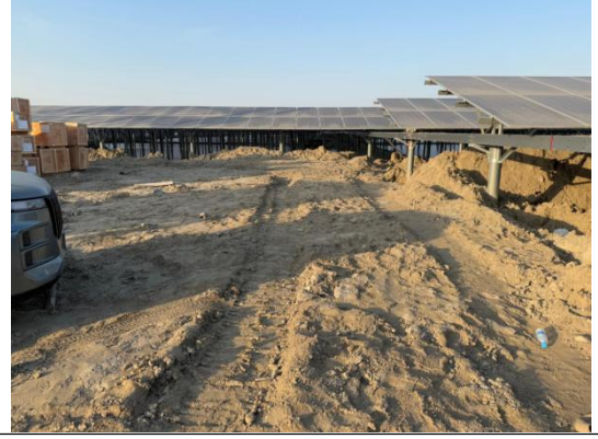
图 3-2 架空线路沿线周边环境现状
