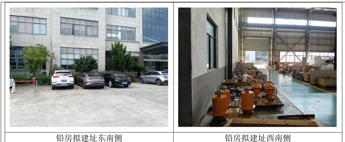
图 8-1 项目周边现状照片
