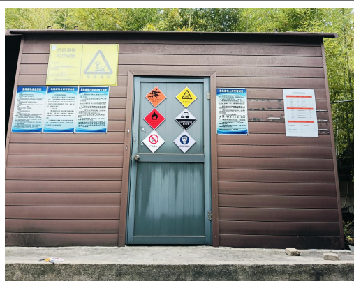
图 3-19 危废堆放处门口
