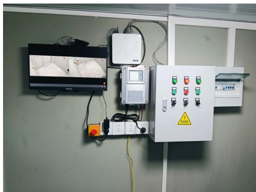
图 3-10 操作台紧急停机按钮
