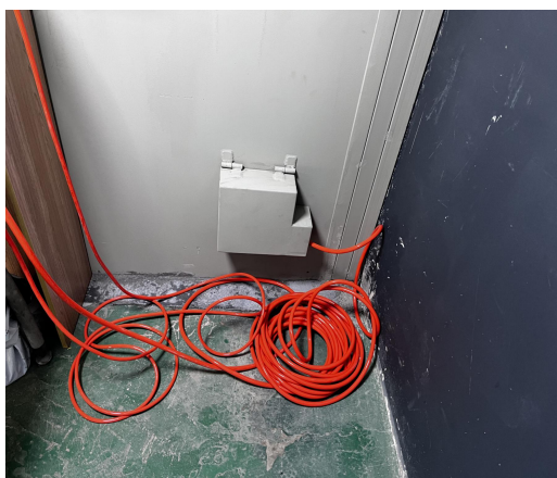
图 3-12 电缆线穿线管防护
